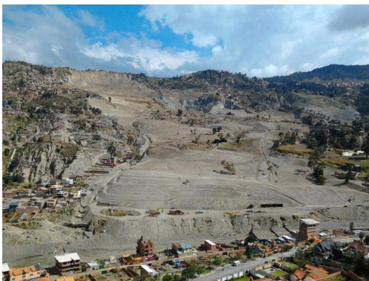
**Ilustración 32. Vista del deslizamiento de Pampahasi bajo Central a los tres meses después del suceso.**
